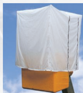
取り付け完了状況
