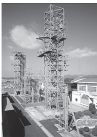
屋外試験鉄塔群
