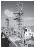
屋外試験鉄塔群
