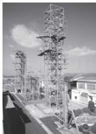
屋外試験鉄塔群
