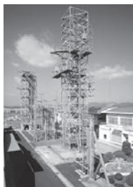
屋外試験鉄塔群
