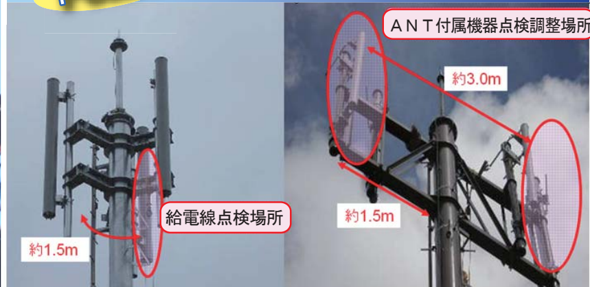
給電線点検場所
