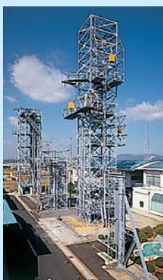
屋外実証鉄塔群
